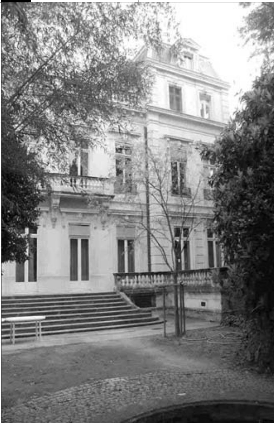
L'Hôtel Villarmois fait l'objet d'une opération de rénovation
