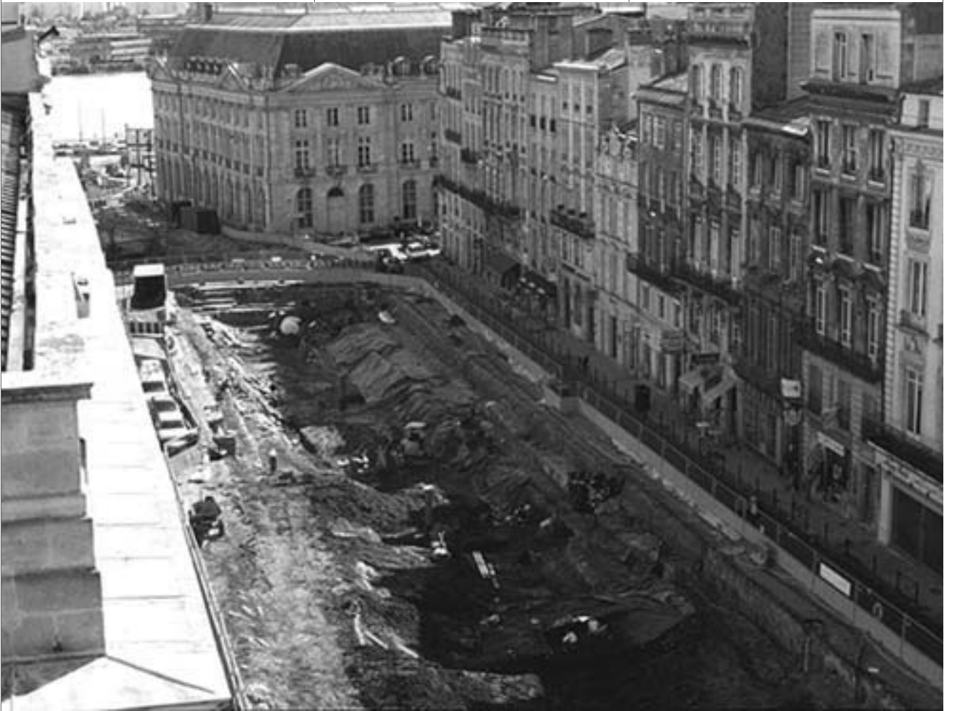
Bordeaux, cours du Chapeau-Rouge, construction d'un parking souterrain. Vue générale, d'ouest en est, du chantier archéologique. Dégagement du fossé médiéval, qui recoupe des vestiges allant du XX e siècle jusqu'au début de l'antiquité.
